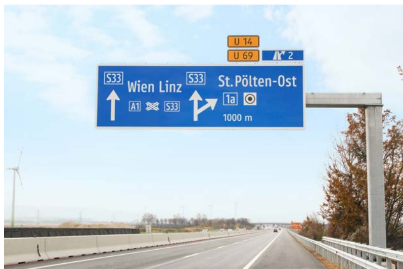
Wechselwegweiser in Prismentechnik auf einer T-Tragmastkonstruktion.
