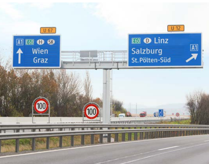
Wechselwegweiser in Prismentechnik auf einer T-Tragmastkonstruktion.
