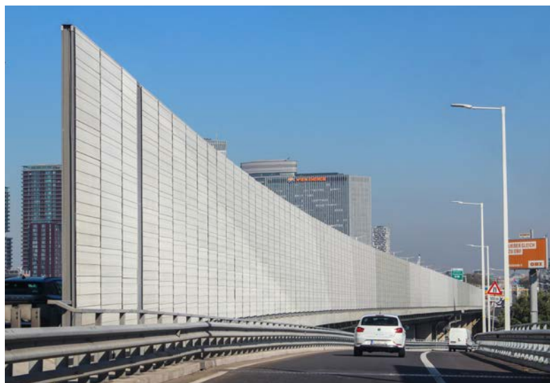
Die Nuancierung der Farben mit teilweise zweifarbigen Schrägübergängen schafft eine feine Harmonie.
