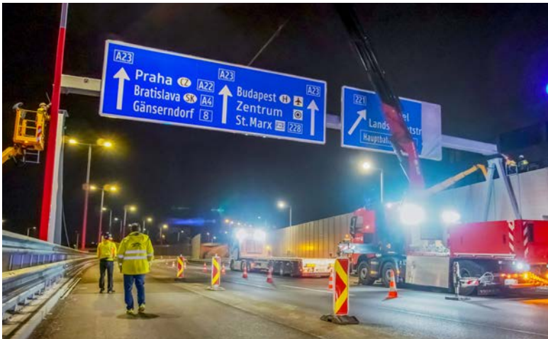
Die Montagearbeiten erfolgten vorwiegend in der Nacht.
