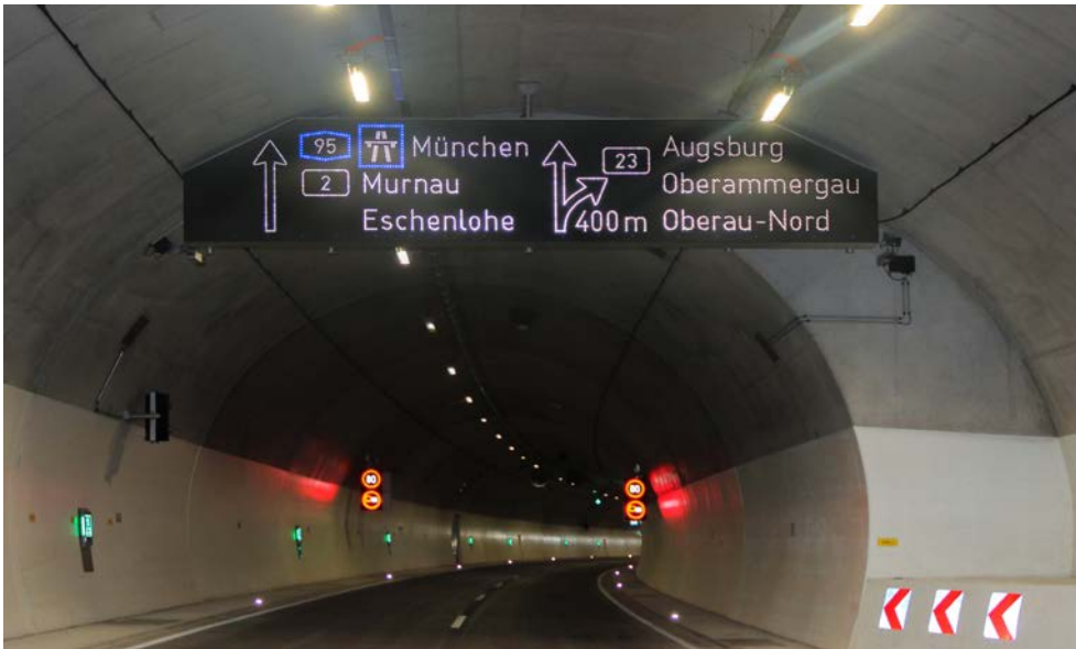
Der Ausfahrtswegweiser in LED-Technik ist eine projektspezifische Sonderkonstruktion mit abgeschrägten Ecken.
