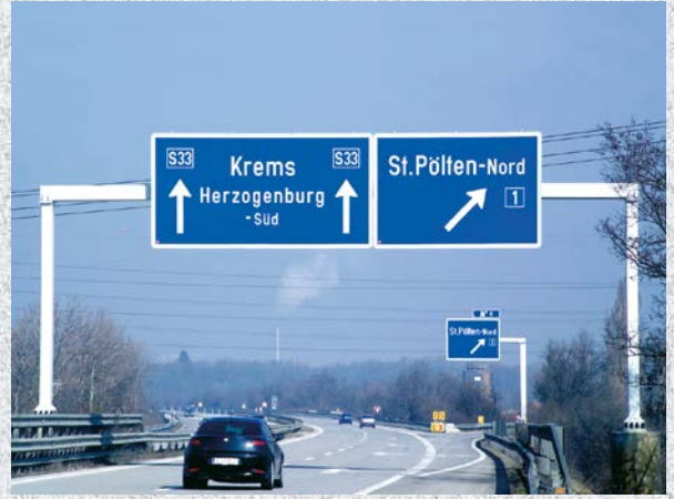
Schilderbrücken und Kragkonstruktionen
